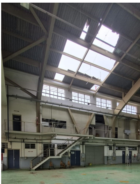
Figura 11- Ponto de destelhamento do H- 03.
