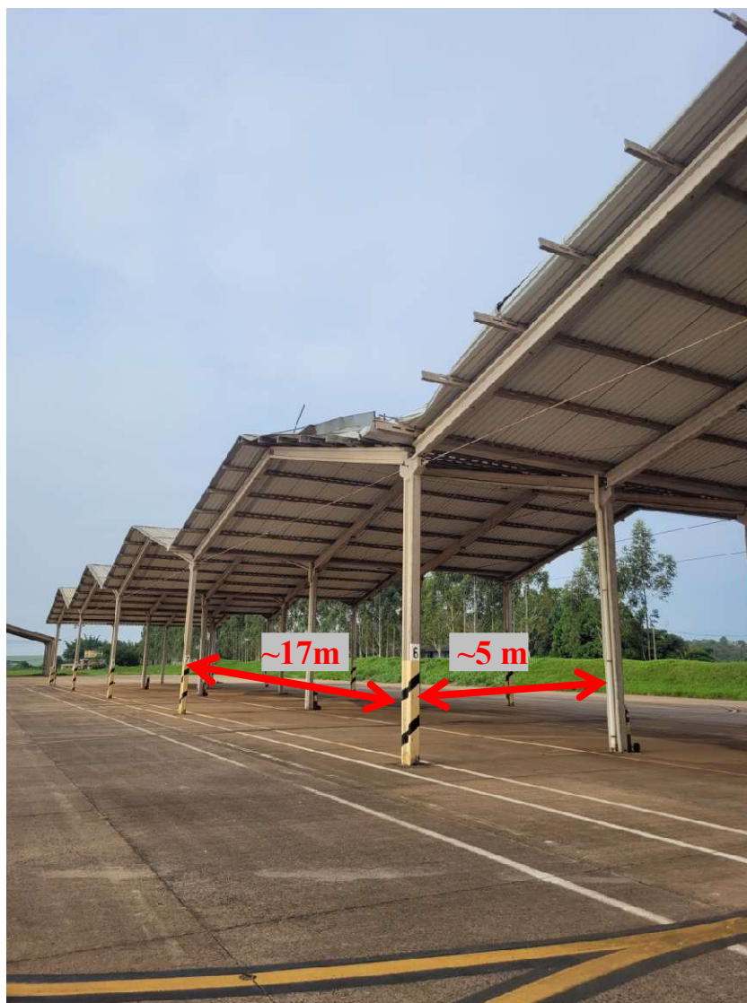
Figura 21 - Dimensões dos vãos da estrutura dos hangaretes
